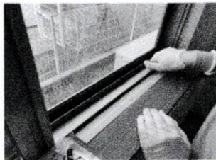
窓のサッシも綺麗になっている様子
